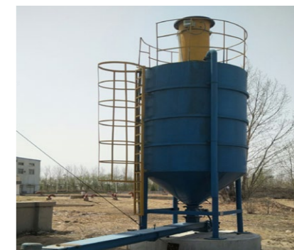
鍋爐大氣除塵脫硫系統
